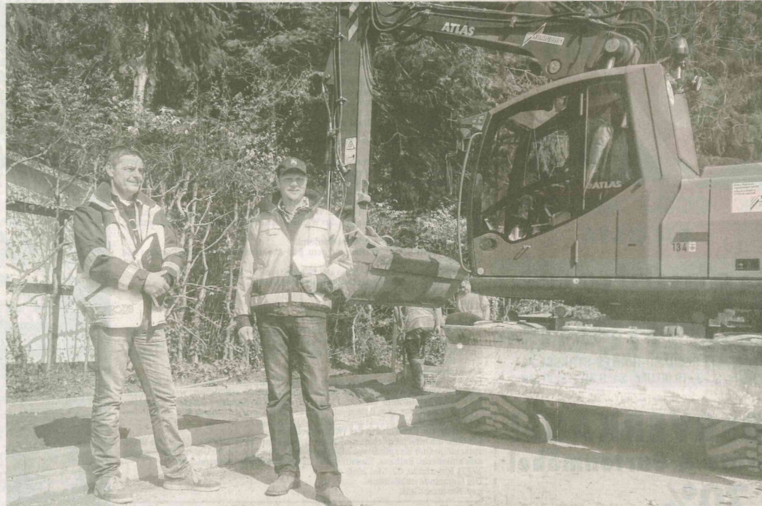
In Vollersode läuft's rund! Die Ingenieure Uwe Albers (links) von der IWU Zeven und Thomas Mehrstens vom Landkreis Osterholz sind zufrieden mit dem Fortgang der Straßensanierung. Im September soll auch der zweite Abschnitt fertiggestellt sein. FOTO: MICHAEL SCHÖN
