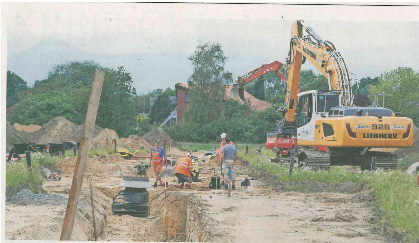
Im neuen Baugebiet Osteracker-Süd in Schiffdorf wird tief im Geestboden gegraben. Kanal und Baustraßen fürs Neubaugebiet entstehen.
